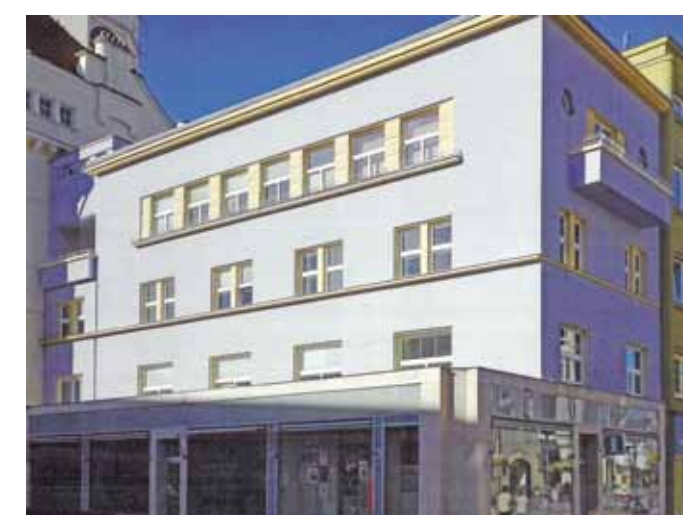
Generální oprava historické fasády domu v sousedství opavské Hlásky - dnes kanceláře MMO.
