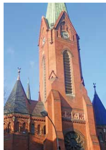
Oprava havarijního stavu věže včetně výměny břidlicových žaluziových desek.
