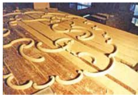
Rekonstrukce a restaurování stropu vysokého Tanečního sálu po havárii dřevěného stropu zničeného dřevokaznými houbami.
