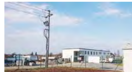
Navýšení trafostanice v Hněvotíně po realizaci.
