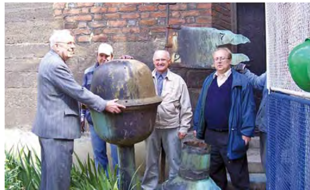
Generální oprava celé vrcholové partie věže, rozsáhlá oprava krovu, repase báně, korouhve a kopie kříže (2. etapa).
