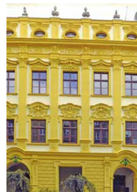
Restaurování štukové výzdoby na fasádě budovy a doplnění do původního stavu dle historické fotodokumentace.
