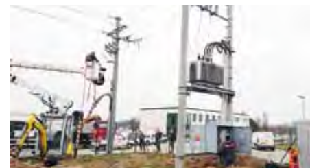
Navýšení trafostanice v Hněvotíně před realizací.
